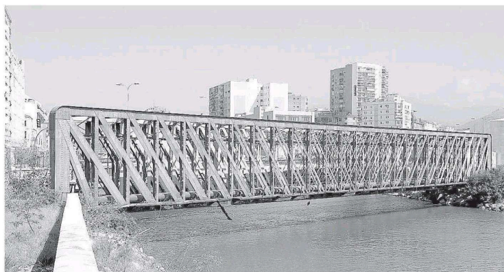
El puente metálico, de 74,5 metros de longitud, data de principios del siglo pasado. :: NITO SALAS
