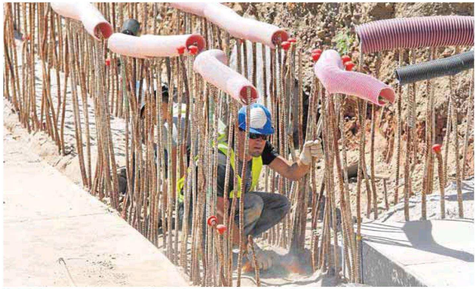
Trabajadores, ayer en el tramo del suburbano en la glorieta de Albert Camus. :: ÁLVARO CABRERA
