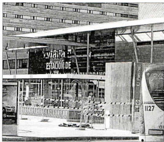
Zona en la que comenzarán los trabajos. L.O.
