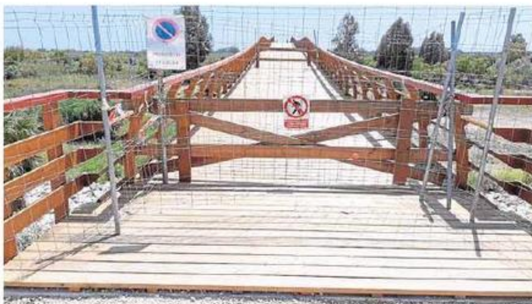
Urbanismo ha reforzado el vallado de la pasarela tras comprobar que estaba siendo usada sin estar terminada. sue
