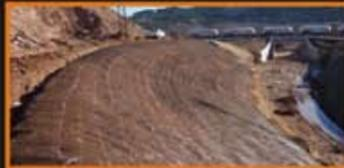
**NAG C550.** La Geomalla se ha desarrollado para obtener un rendimiento superior en el control de la erosión y un refuerzo de la zona de plantación. Esta geomalla se adapta a pendientes extremas, canales con flujo constante y velocidades altas.
