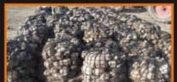
**Chamber revetment.** Gavión laminar de 4 x 2 x 0,2 de 400 kg/m<sup>2</sup>. compartimentado en 5 cámaras, relleno de piedra, estructurado en una red de polipropileno de 45 mm. de malla y 6,5 mm. de grueso.
