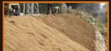
**Rock Roll.** Gavión flexible de 0,4 m. de diámetro y 2 m. de longitud, estructurado en una red de polipropileno de 50 mm. de malla y 4,5 de diámetro y relleno de piedra de un peso de 175 kg/ml.
