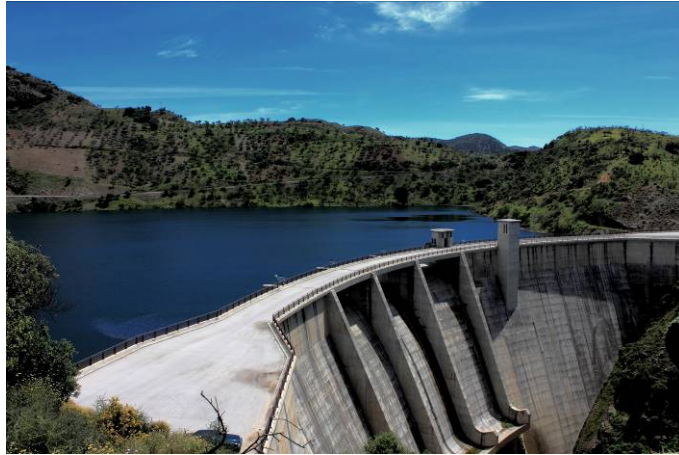
Figura 51. Presa de Casasola
