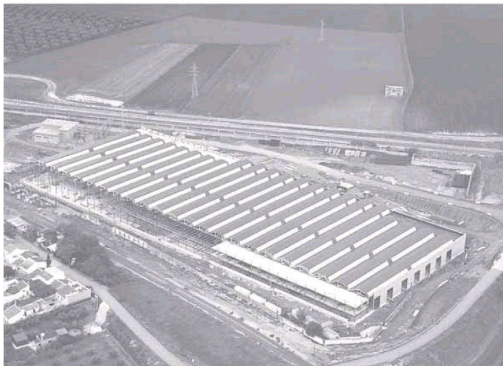
Vista aérea de las naves construidas en Bobadilla, que eran el destino de este contrato. :: sur
