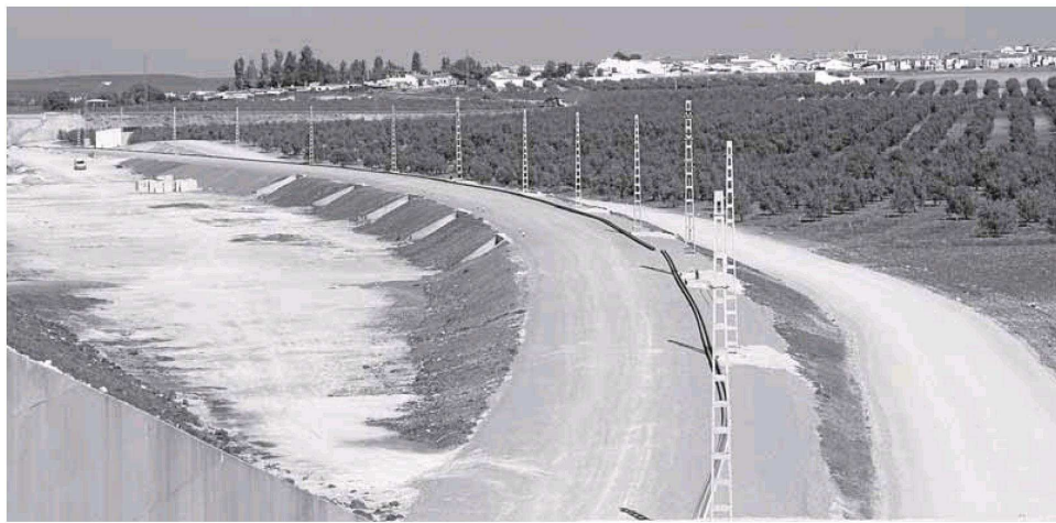
Tramo de la plataforma ya construida entre Antequera y Marchena del Corredor Ferroviario Transversal, paralizado desde 2011. :: SUR
