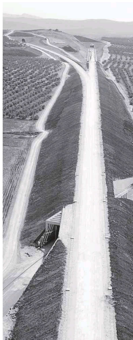
Plataforma de la línea Antequera-Sevilla. :: sur
