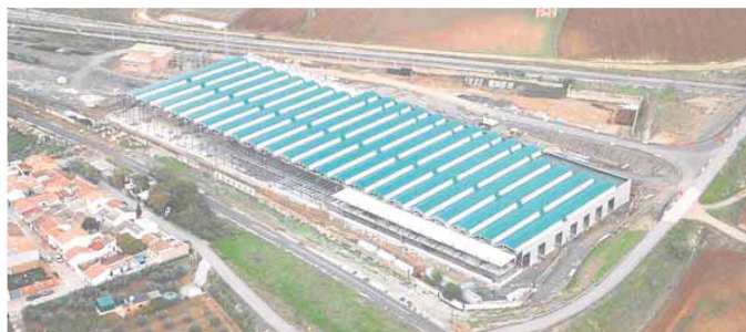
Las naves de apoyo al anillo, construidas en Bobadilla, están actualmente sin uso. :: SUR
