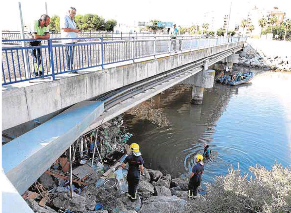
Bomberos inspeccionan la chabola que existe bajo el puente. :: SALVADOR SALAS
