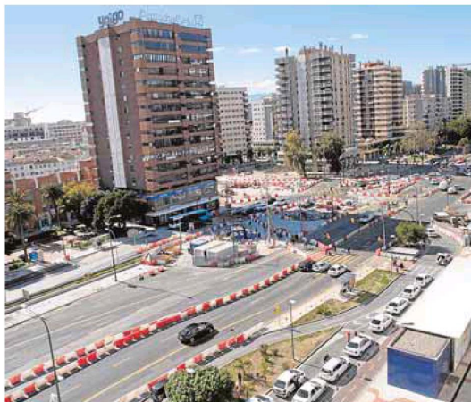
Desvíos de tráfico en la avenida por los trabajos del metro. :: A. CABRERA
