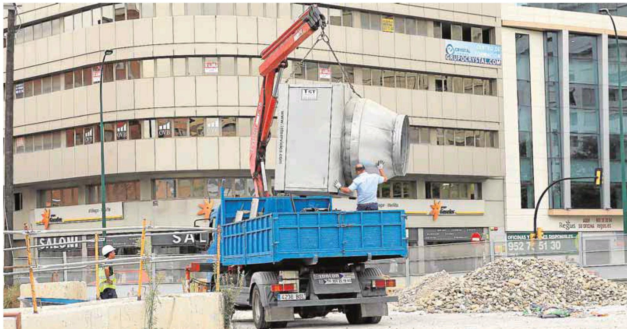
Trabajadores de Ortiz retiran los grandes ventiladores que refrescaban el aire en el túnel de Callejones del Perchel. :: SALVADOR SALAS
