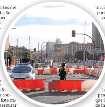
Obras del metro en la Avenida de Andalucía. :: S.SALAS
