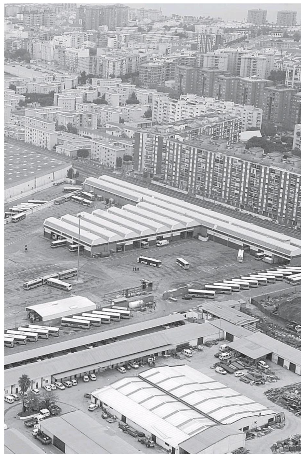
Entorno del Camino de San Rafael sobre el que se actuará. :: sur
