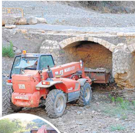
Una máquina retira la tierra que ciega un puente sobre el Arroyo Jaboneros. Abajo, trabajos en el cauce. Derecha, desperfectos en el pavimento. :: J. M. A. / JUAN LÓPEZ
