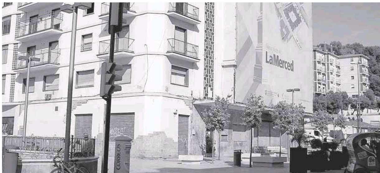
El estado de deterioro del edificio que albergó los antiguos cines Astoria y Victoria es evidente en plena plaza de la Merced. :: SUR
