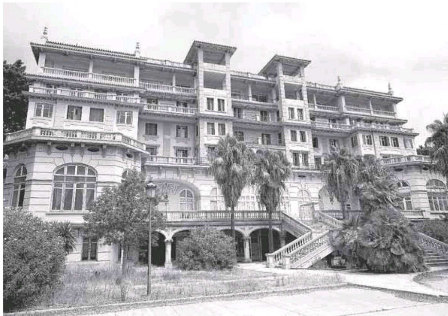
Vista de la parte trasera del edificio, de la fachada que da al paseo marítimo. :: SUR
