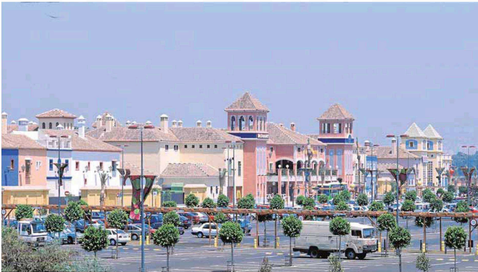
La nueva zona comercial se ubicará en terrenos actualmente ocupados por aparcamientos en superficie. :: SUR
