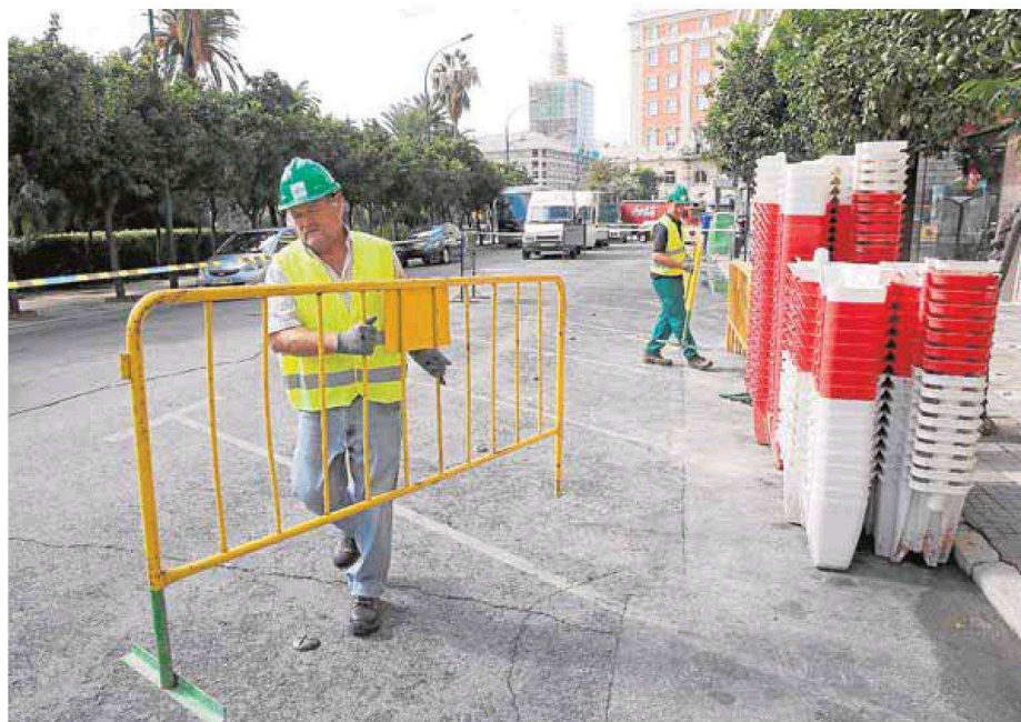
La única zona ocupada por ahora es la mitad norte de Cortina del Muelle para acopio de materiales. :: S. SALAS
