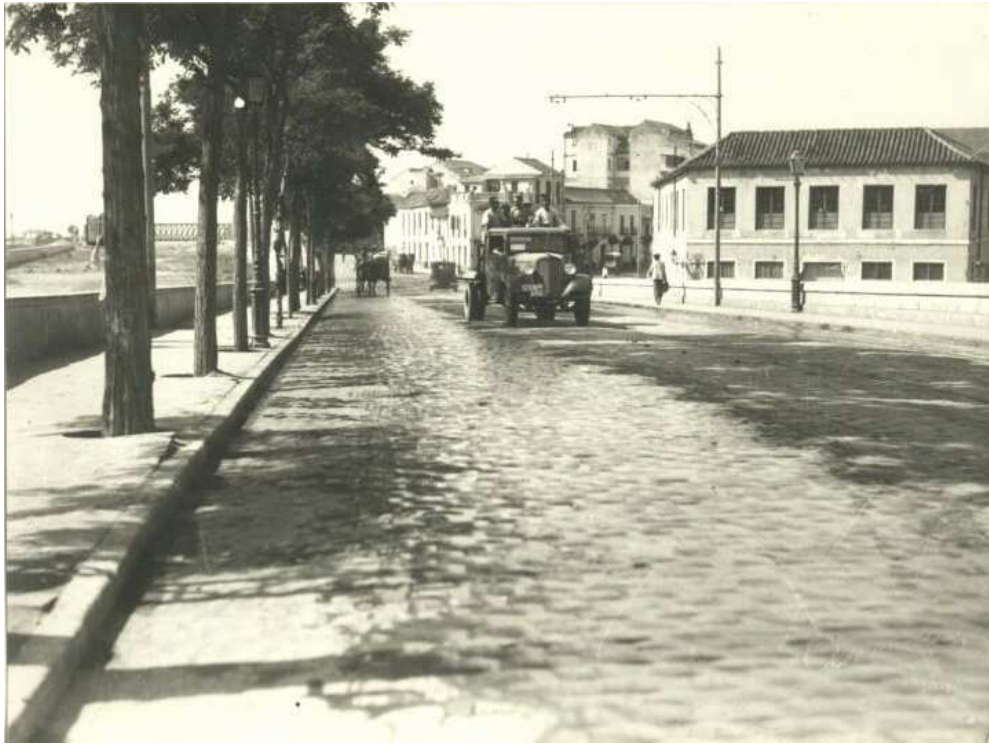
Rampa de subida al puente de Tetuán por calle Cuarteles.
