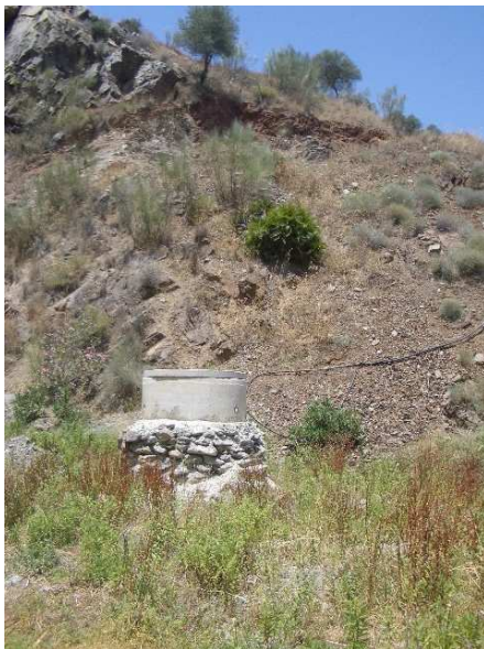
Pozos de riego sobre el cauce del río.
