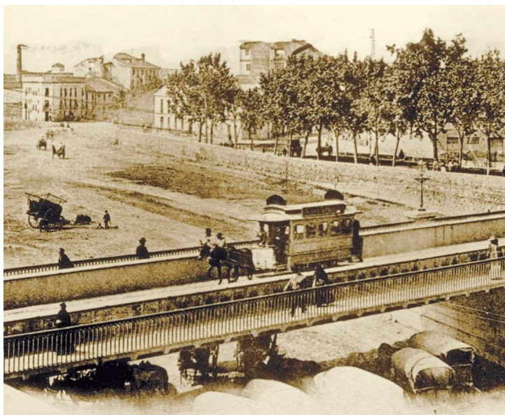
Puente de Tetuán proyectado por Luis Gracián y Reboul en 1860.
